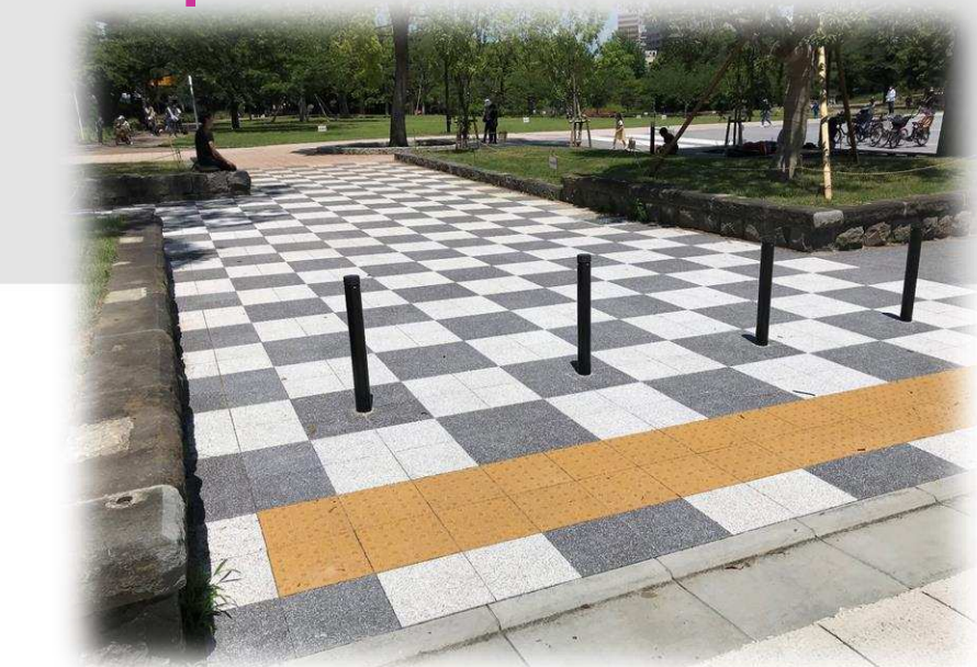
エントランスイメージ② (ポール型車止め+点字シート)
